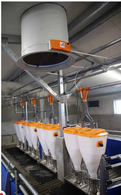
Wyposażenie komory (tubomaty, komin wyciągowy) i stalowa konstrukcja dachu
