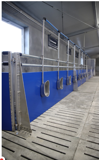
Ruszt, wygradzenia, poidła, okna i wloty powietrza
