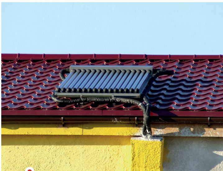
Kolektor słoneczny rurowo-próżniowy (Fot. Energy-Projekt Robert Szulc)
