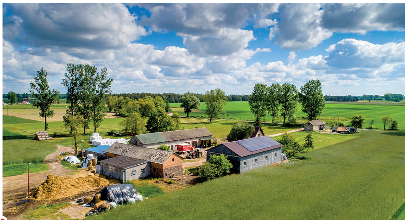
Gospodarstwo rolne z instalacją fotowoltaiczną o mocy 14,63 kWp (Fot. Columbus Energy S.A.)
