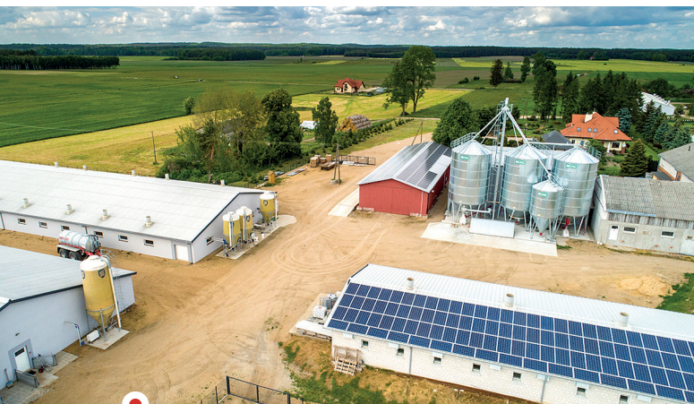
Dwie instalacje fotowoltaiczne o mocy 49,4 kWp każda, zamontowane na dachach budynków gospodarczych (Fot. Columbus Energy S.A.)
