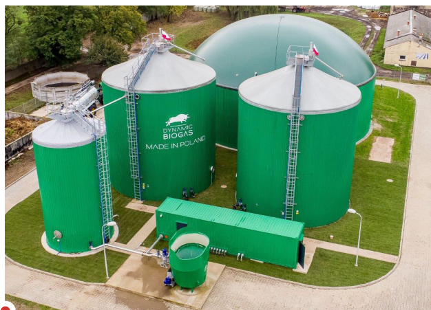
Fot. 2. Mała biogazownia III generacji o mocy 500 kW pozwala na uzyskanie przychodu blisko 3 mln zł rocznie
