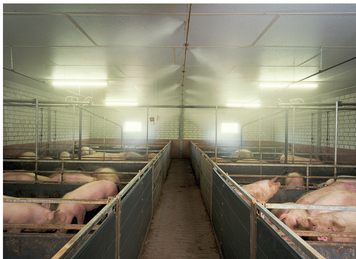
Delikatna mgiełka z CombiCool skutecznie obniża temperaturę bezpośrednio w otoczeniu zwierząt
